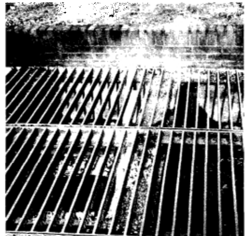
Aluminium tranenplaat -plankjes in het wildrooster
